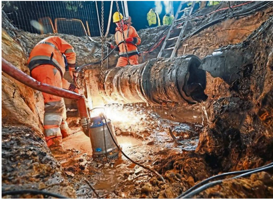
In einer nächtlichen Aktion tauschten die Mitarbeiter des OOWV die alte Wasserleitung gegen eine neue mit einem größeren Durchmesser aus.
