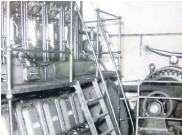
Torfgas speiste die riesige Verbrennungsmaschine (umgebauter Schiffsdiesel) mit Stromgenerator.
