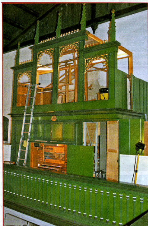
Ausgehöhlt: Das Gehäuse der Heyder-Orgel während der Sanierung im vergangenen und in diesem Jahr.
